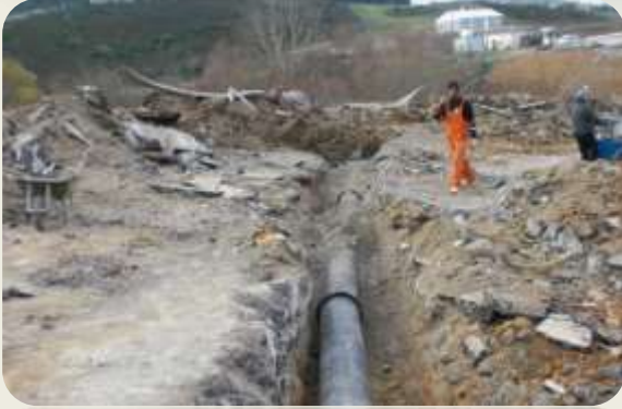
İSTANBUL GENELİ YENİ YOL YAPIMI ve YOL GENİŞLETME İNŞAATI İŞİ İşveren: İstanbul Büyükşehir Belediyesi Fen İşleri Daire Başkanlığı Alt Yapı Hizmetleri Müdürlüğü
