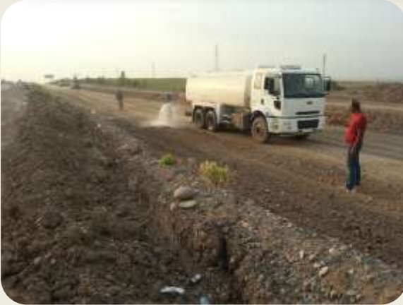
ERBİL-KHABAT YOLU 6300M YOL İNŞAATI
